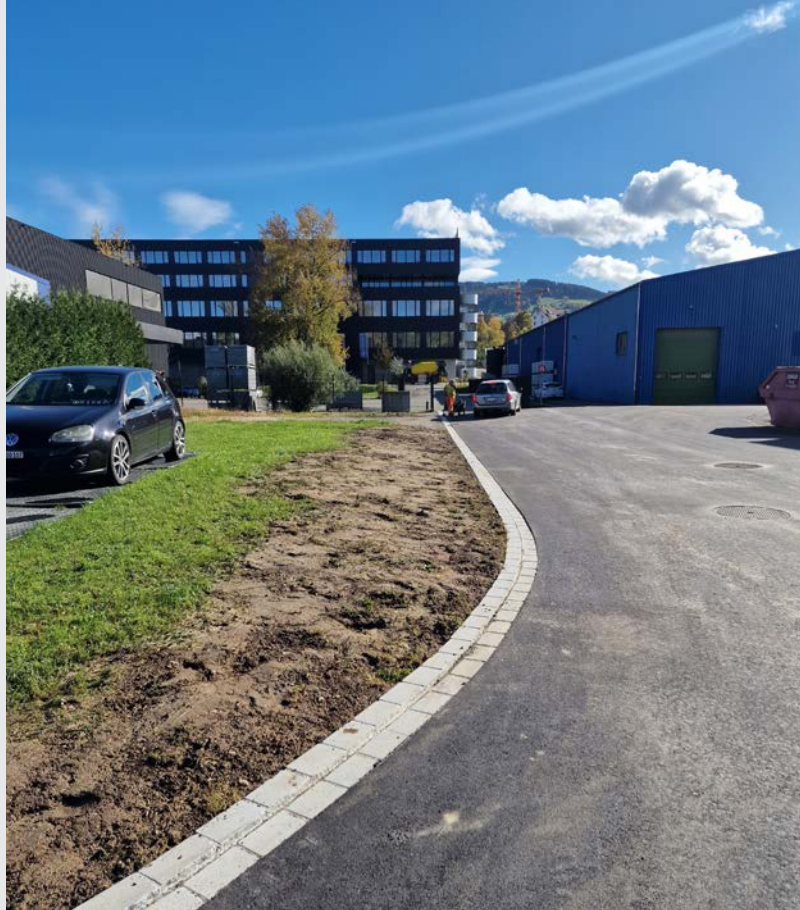
Strassensanierung im Schuppis
