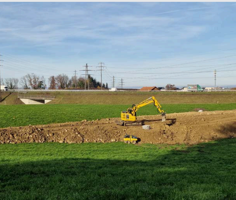
Start der Arbeiten des Projekts Bodenverbesserung
