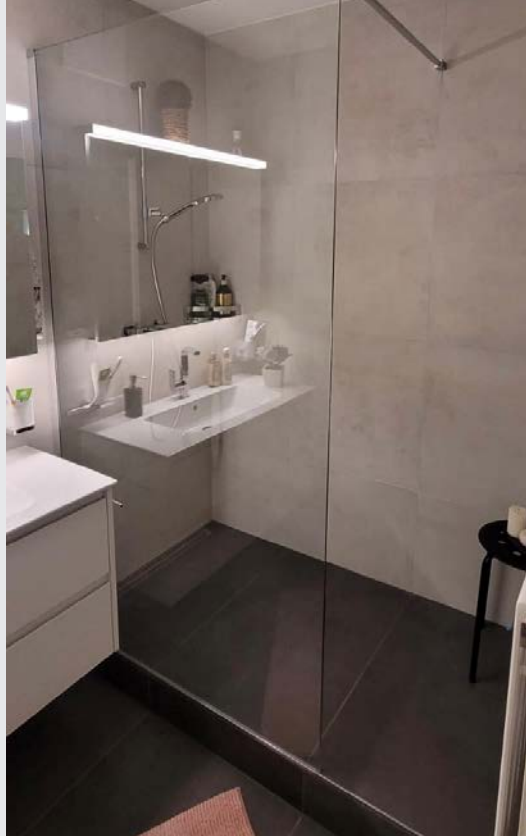
Sanierung Nasszelle Warteggweg 24/24a
