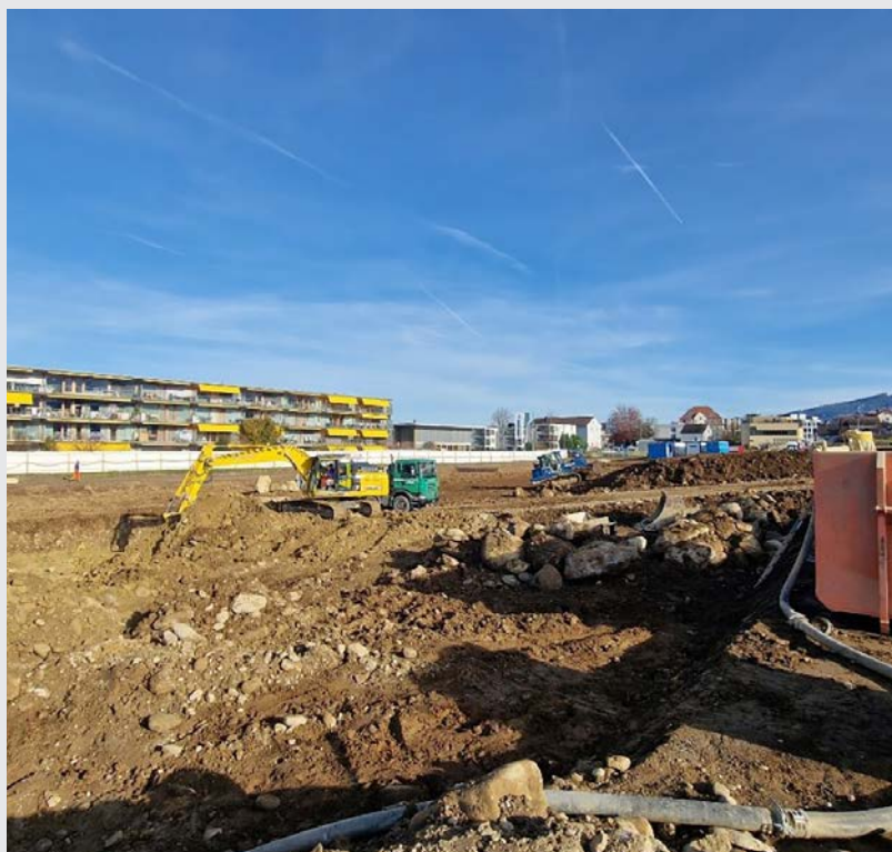
Bauarbeiten auf den Baufeldern 2 und 3
