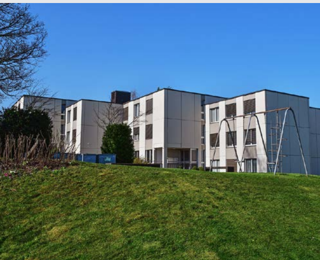
Liegenschaft Warteggweg 24/24a
